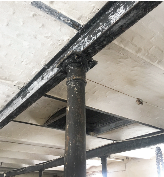
Støbesøjler og Kalkede hvælv i den gamle stald
